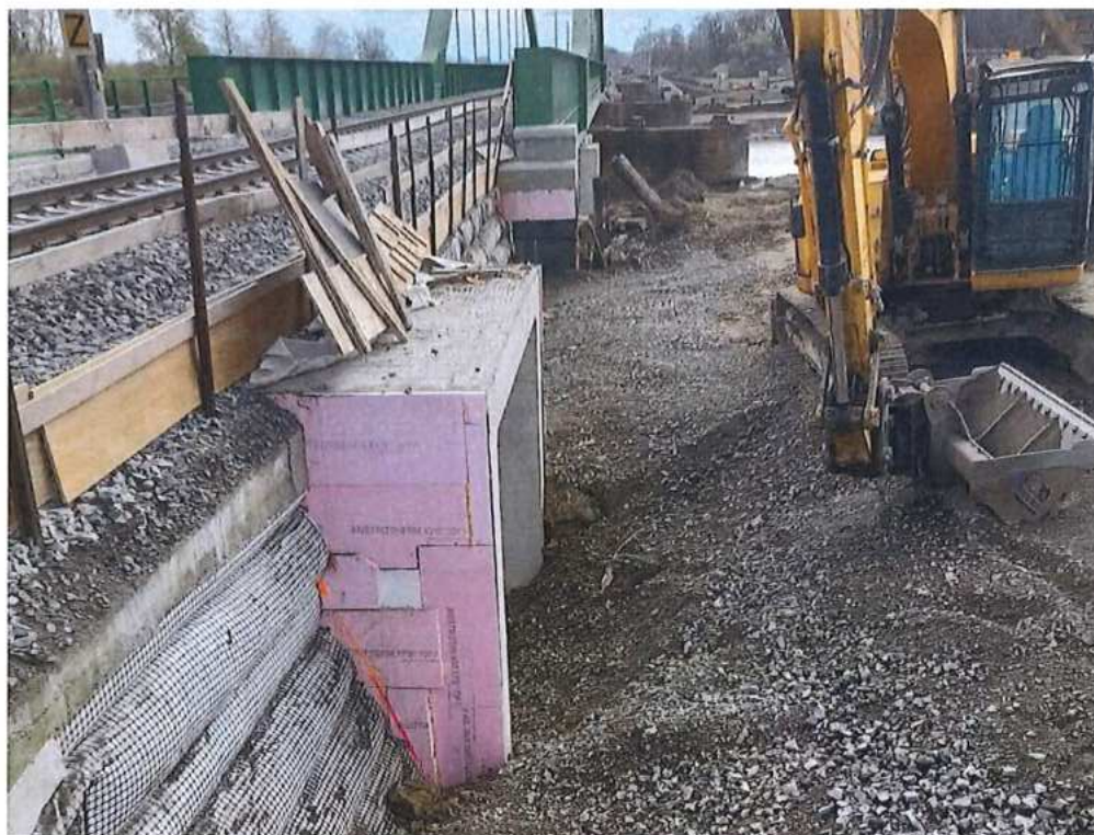
Zemné práce po vytiahnutí larsen – SO 12-33-05 (13-33-02)
