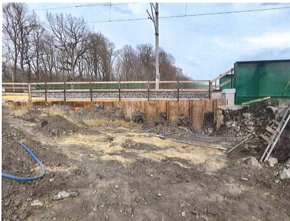
Zemné práce – príprava na vytiahnutie larsen – SO 12-33-05 (13-33-02)
